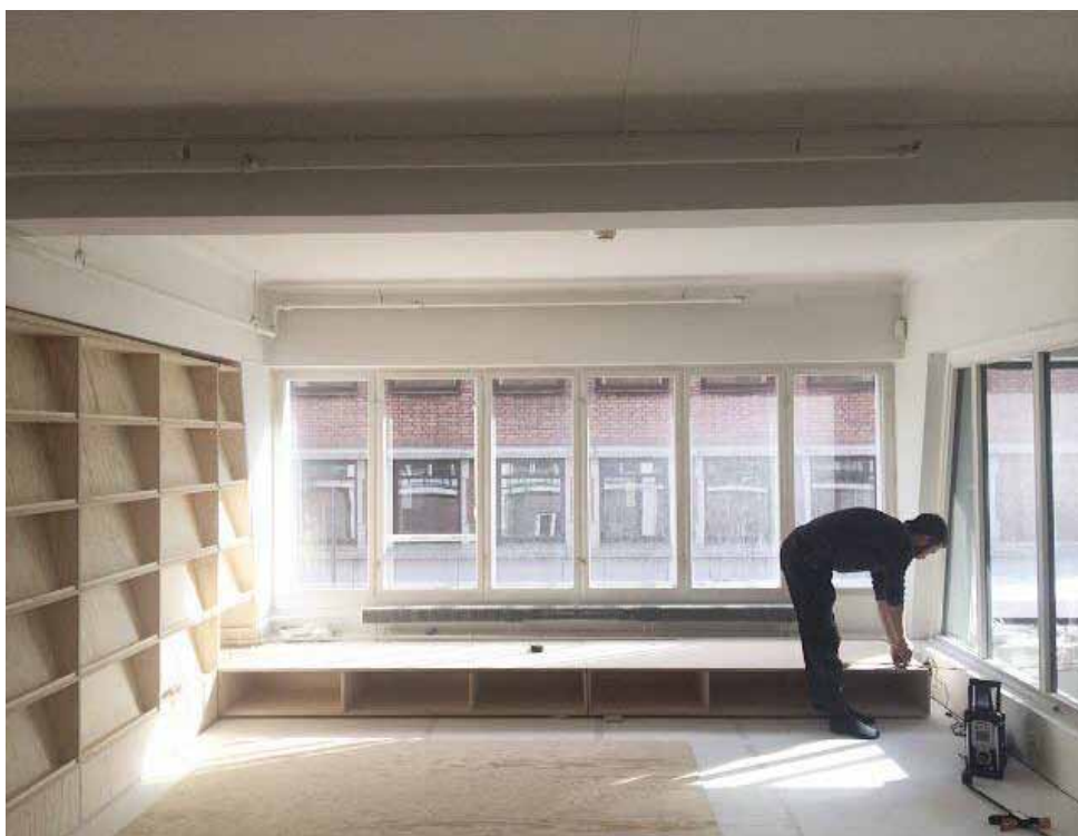
Atelier Felix under ombygging, våren 2015. Foto: Superunion
